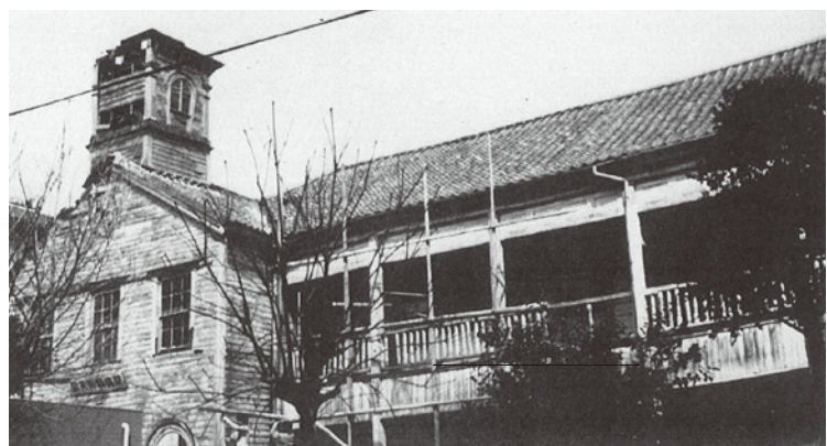
▲昭和43年 保存修理工事前の状態
