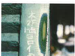
▲保存修理工事調査写真 表面の水色のペンキを削った様子
