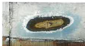
▲保存修理工事調査写真 表面の水色のペンキを削った様子
