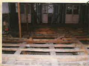
▲保存修理工事写真
